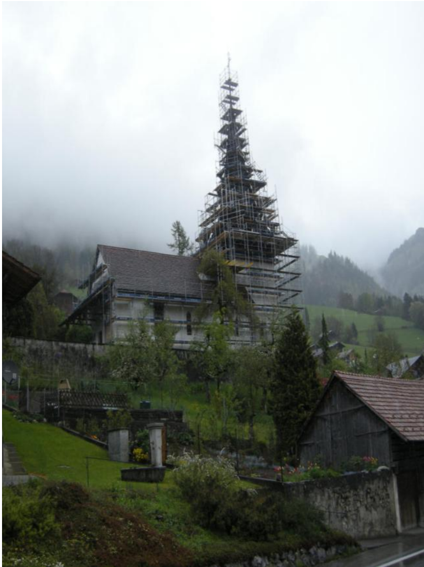
Das Gerüst ist fast komplett
