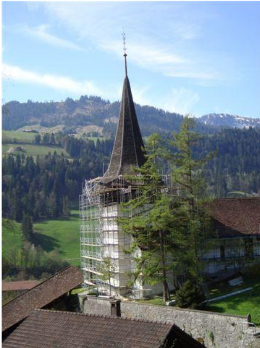
In der Aufbauphase des Gerüstes
